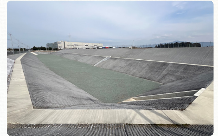
JASM 廠區涵養水工程的涵養池
