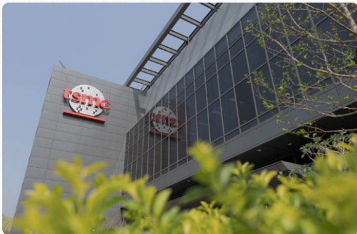
台積電公司打造「供應商環境資訊數位平台」提升供應鏈環境管理能
