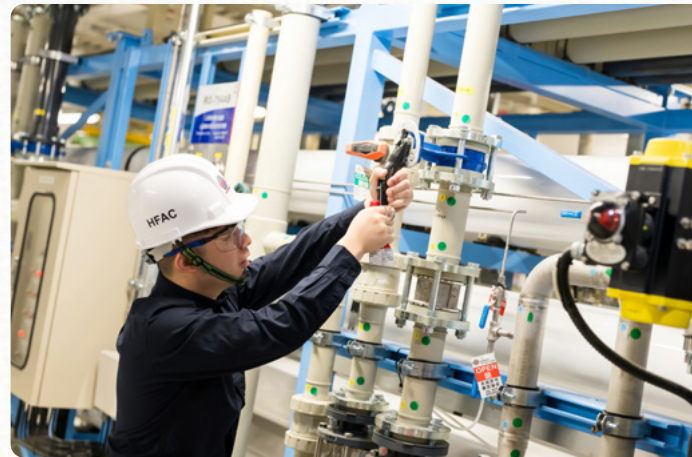
台積公司將氨氮廢水依濃度進行分流，增進處理效率
