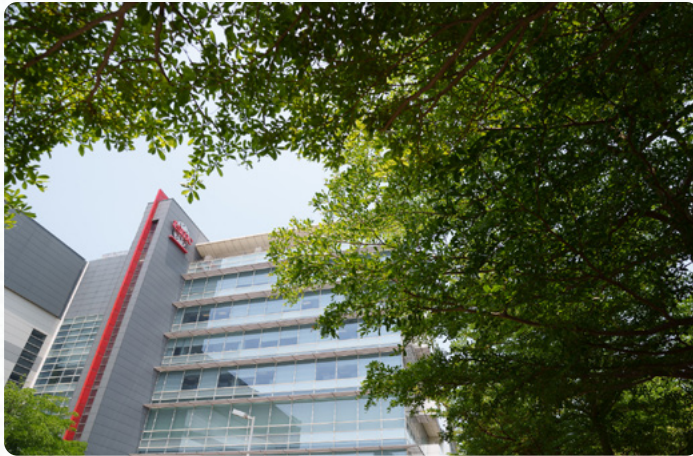
台積公司將再生水導入先進製程廠區使用
