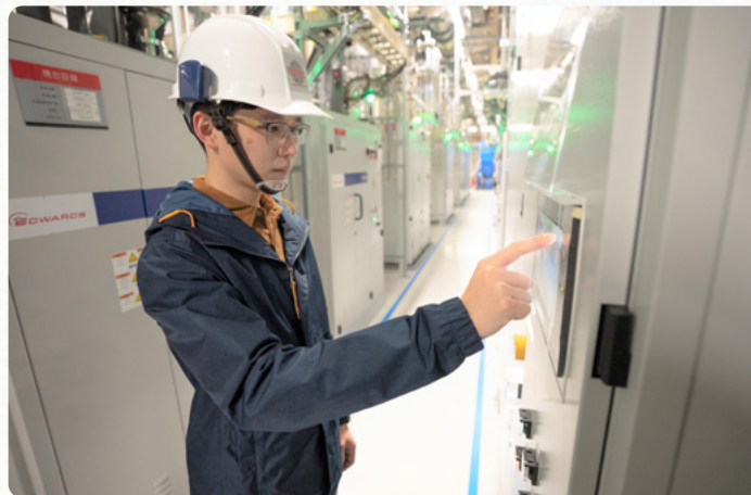
台積電公司攜手供應商改造現址式處理設備，降低氮氧化物排放
